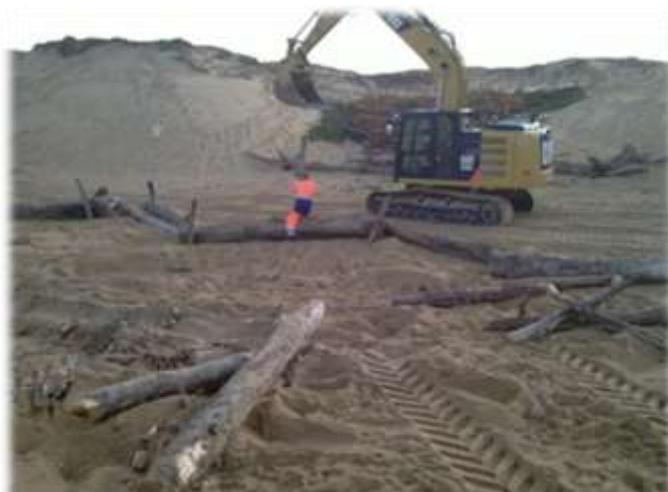
L'épi a été installé « en W », sur une longueur de 180 m. Le positionnement correspond à environ 10 m du pied de falaise, car trop proche de la falaise, le flux risquerait d'attaquer directement le sable ; un espace entre le dispositif et le pied de dune devrait normalement atténuer les effets du flux, en réduisant sa force, ainsi que celle de l'onde de retrait.
