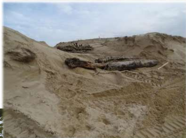
bouchage de siffle- vent, en vue de fixer les sables.
